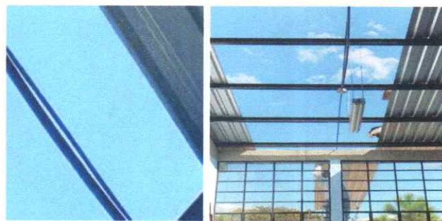
Foto 2: Instalando Cubierta de lámina
