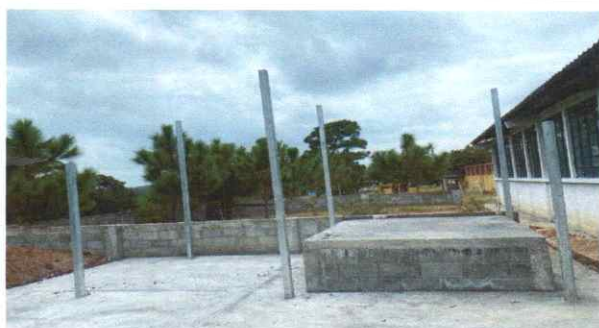
Foto 3: Instalando estructura de Soporte de metal galvanizada
