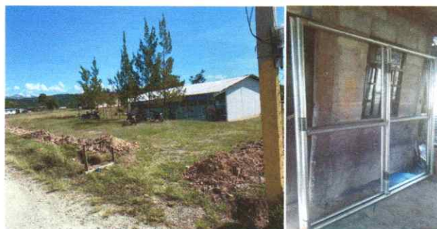
Foto 4: Trabajando bases de portón de tubo y malla e instalando zapatas y elaborando el mismo
